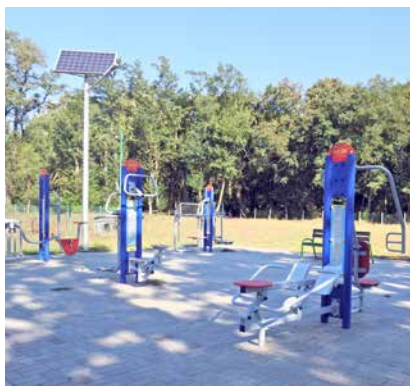
Budowa siłowni zewnętrznej w Gorzycy Koszt – 45 597,79 zł
