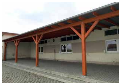
Zadaszenie tarasu przy szkole podstawowej w Bukowcu Koszt – 18 056,00 zł
