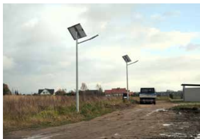
Budowa oświetlenia na drodze gminnej Międzyrzecz – Wybudowanie Koszt – 13 284,00 zł
