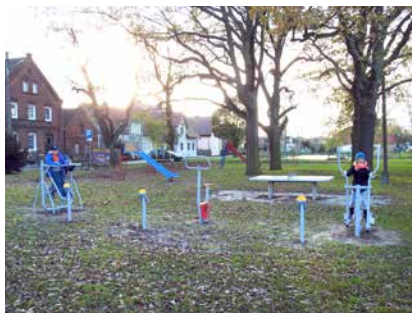
Budowa siłowni zewnętrznej w Kaławie Koszt – 16 230,00 zł
